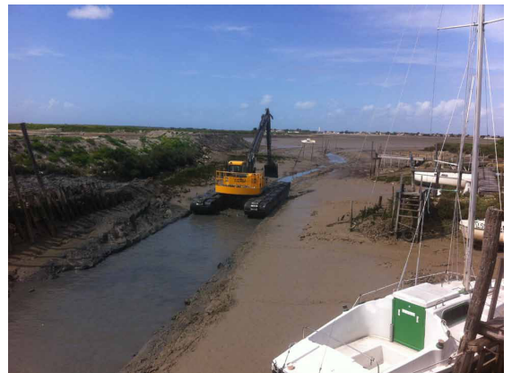
Travaux de reprofilage du chenal du port du Goisil à La Couarde sur mer
