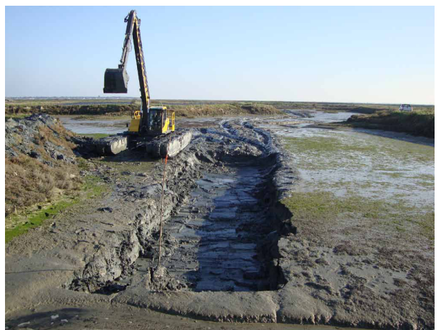
Reprofilage et curage du chenal des Rouets
