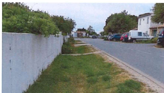
Noue urbaine - Route du Groin
