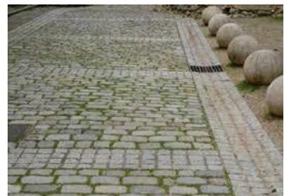
Exemples d'aménagements de voirie étroite : pavés à joints enherbés, alvéoles gravillonnées, chaussée à structure réservoir
