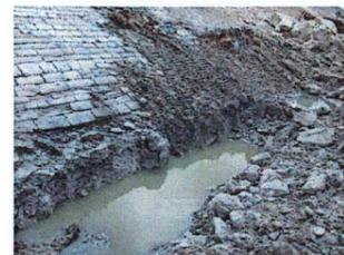
Fouille en pied de digue, en rattrapant le niveau de la banche
