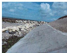
Mise en place des blocs béton en pied de digue (sans pour autant toucher la digue; avec le mouvement de l'eau, l'enrochement cognerait la digue et en fragiliserait à terme le pied).
