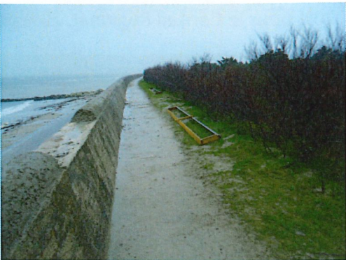
Digue nord - Réfection du parapet
