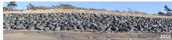
Figure 50. Mise en place des enrochements au niveau de la Pergola (Profil 37).
